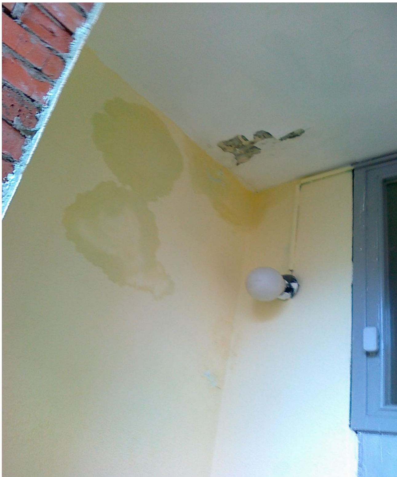
Фото №2 фрагмента входа в тамбур подъезда №3 многоквартирного дома по адресу: 140007, Московская область, г. Люберцы, ул. Урицкого, дом 5, управляемого ТСЖ «Новая жизнь». Ремонт подъезда №3 произведён в 4-квартале 2016 года. Фото сделано 17.03.2017 года
