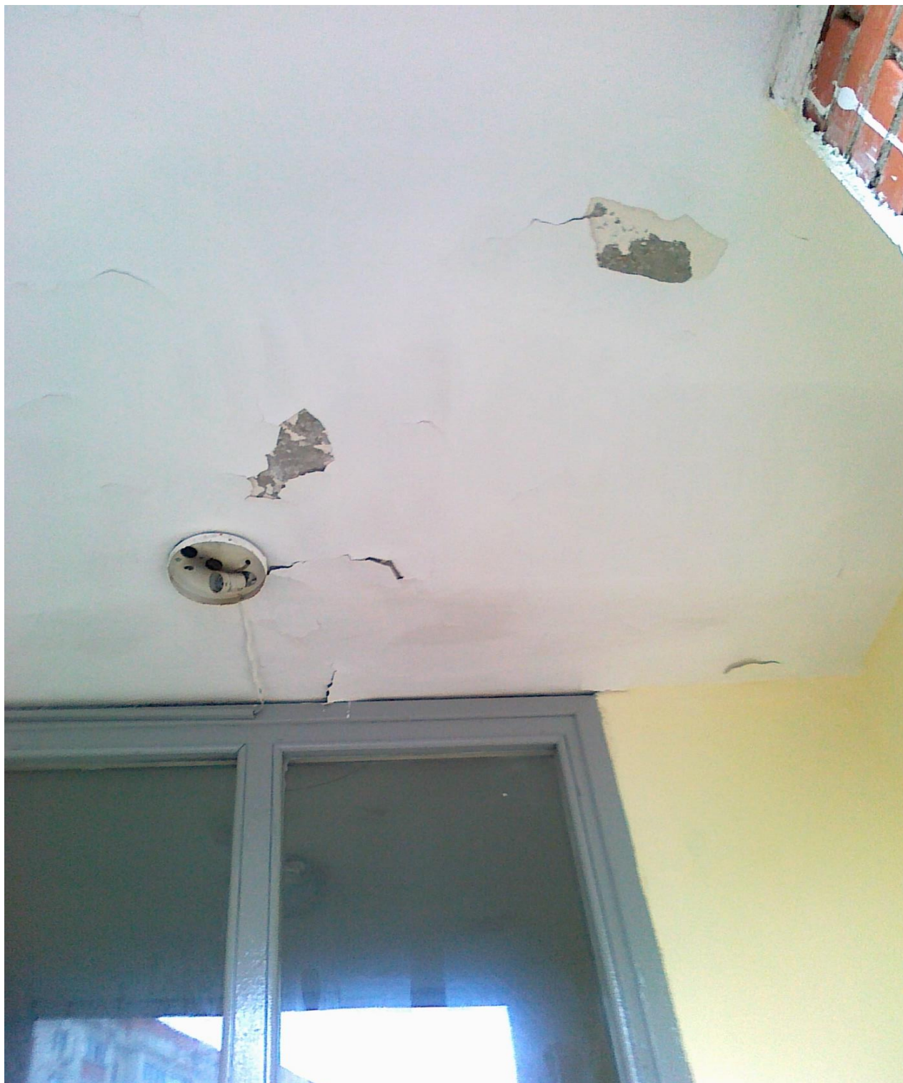
Фото №1 фрагмента входа в тамбур подъезда №3 многоквартирного дома по адресу: 140007, Московская область, г. Люберцы, ул. Урицкого, дом 5, управляемого ТСЖ «Новая жизнь». Ремонт подъезда №3 произведён в 4-квартале 2016 года. Фото сделано 17.03.2017 года
