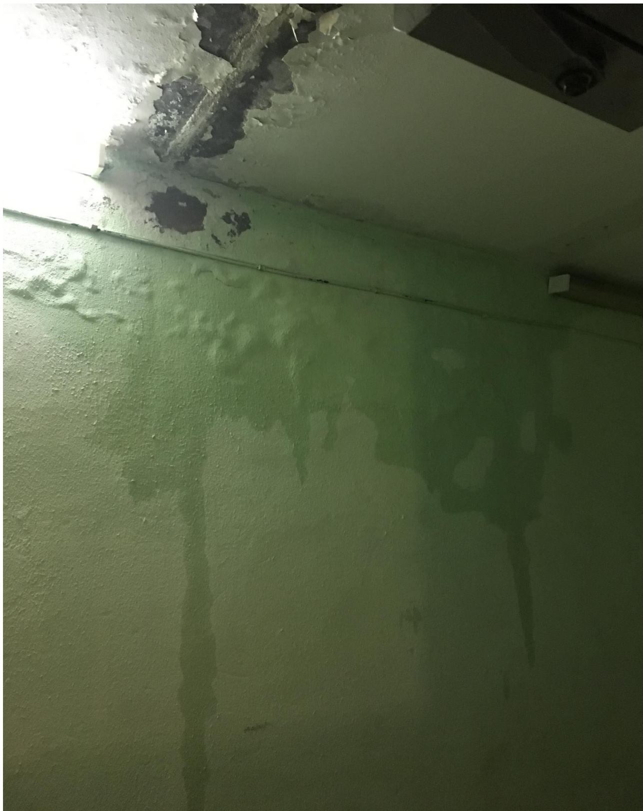
Протечки в тамбуре подъезда №4 многоквартирного дома по адресу 140007, Московская область, г. Люберцы, ул. Урицкого, дом 5. Фото сделано 21.02.2017 года. Управление этим многоквартирным домом осуществляет правление ТСЖ «Новая жизнь».
